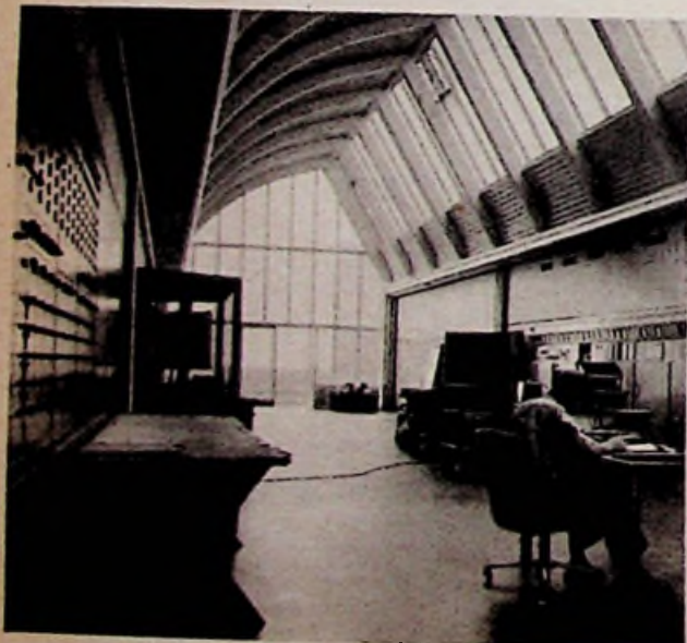
Bild 3. Senderraum; rechts an der Wand die beiden Telefunken-Sender, links das Antennen-Schallfeld (BBC)
